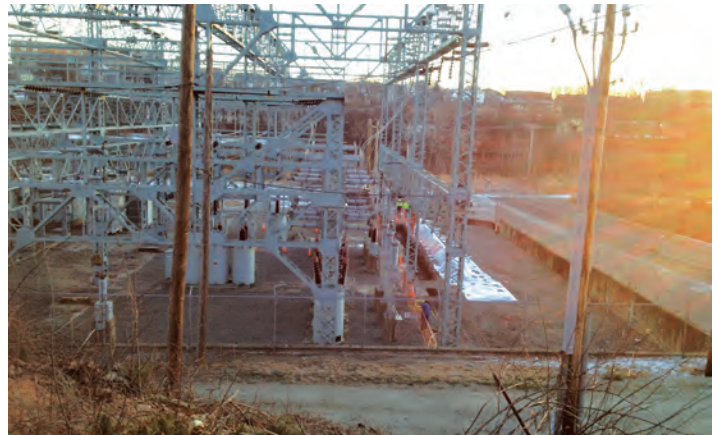
Ya ha concluido la mayor parte de las excavaciones relacionadas a la modernización de la subestación eléctrica Tidewater.
