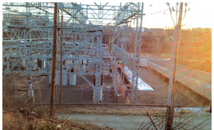
A maior parte das escavações associadas à atualização da subestação elétrica existente de Tidewater está concluída.
